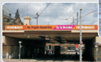
Brückenwerbung Hornbach 18,0 x 0,8m
